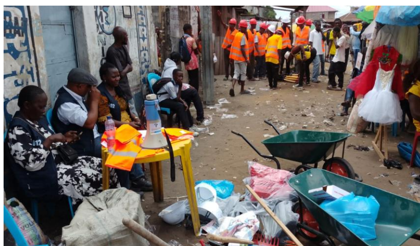
Distribution des EPI aux tâcherons et demarrage des travaux, REEJER-mars 2026
