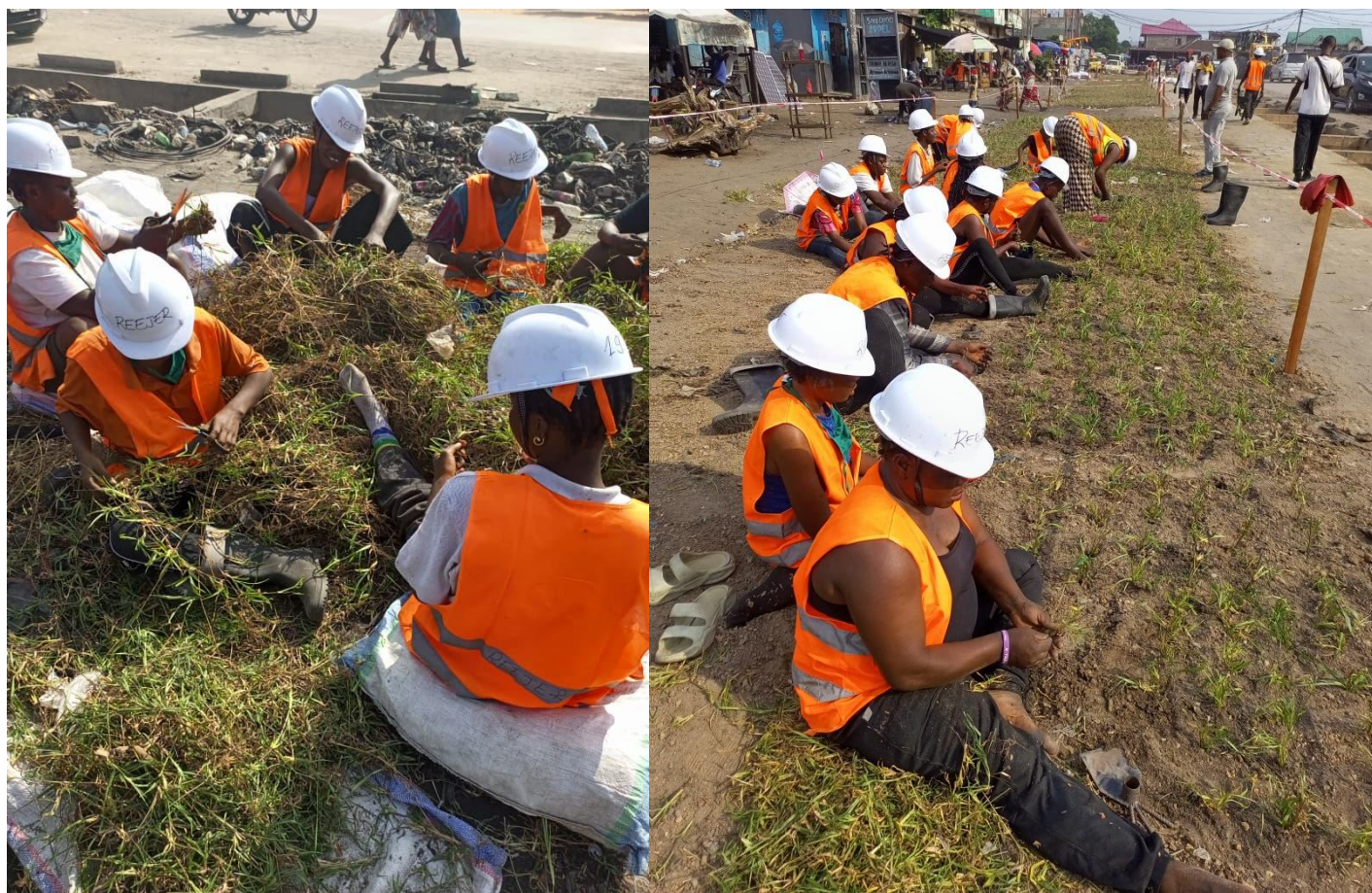
Travaux de découpe de la pelouse et plantation. REEJER-mars 2026
